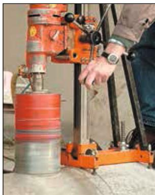
Kreisloch mit Diamant-Bohrkronen rechteckig und zentrisch zur Rohrachse bohren.
