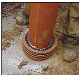
Vor der Montage der Anschlussleitung sind der Dichttring in der Muffe des Stutzens und die Rohrspitze der Anschlussleitung mit DS GV zu versehen. Bei einem abgeschnittenen Rohr muss die Spitze für die Montage angefast werden.
