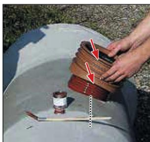
Bohranschlussstutzen zentrisch mit Markierung in Achsenrichtung des Betonrohres bis zum Anschlag in die Bohrung eindrücken. Das zentrische Ansetzen ist wichtig, damit die erste Rippe der Gummimanschette gleichmäßig verpresst wird und nicht umschlägt.
