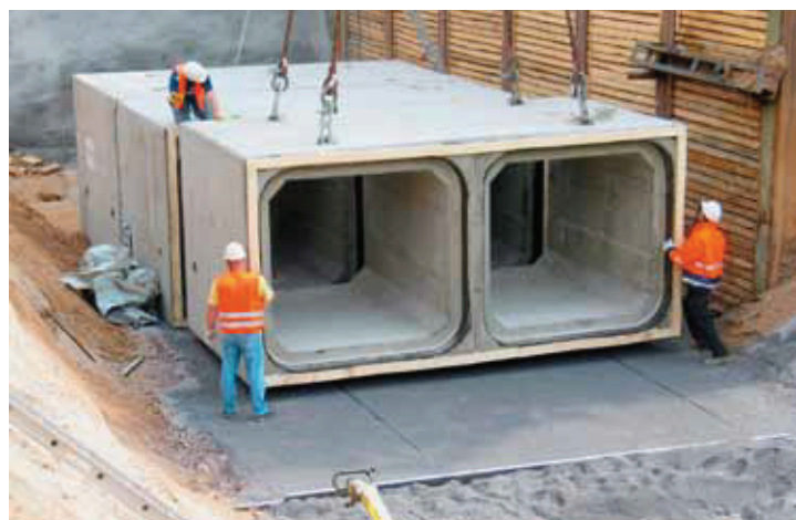
Sewer construction site using box culverts made of reinforced concrete Kanalbaustelle mit Stahlbeton-Rahmenbauteilen
