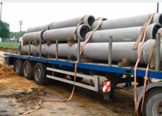
Strenge Sicherheitsmaßnahmen im unmittelbaren Flugbereich erforderten oft das Umladen des Rohr- und Schachtmaterials auf extra lizenzierte Fahrzeuge.
