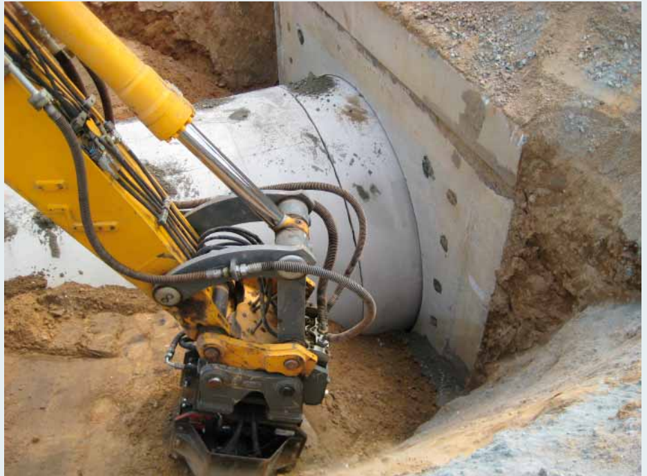
Grabenverfüllung mit Hilfe eines speziellen Anbauverdichters
