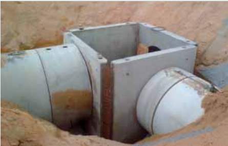
Verbindungsbauwerk von drei gleichzeitig montierten Kanalsträngen
