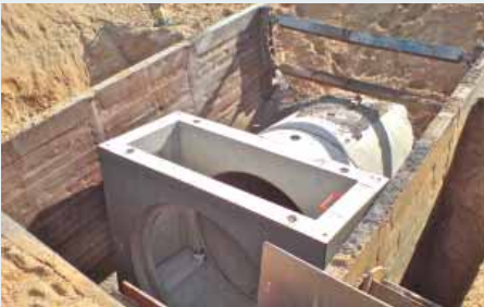
Schachtbaugrube für Großrohre DN 2600. Der schmale Schacht übernimmt die Gelenkstück-Funktion.
