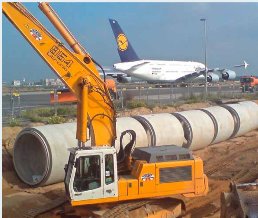
Immer an der Rollbahn lang: Hochbelastbare Stahlbetonrohre vor der Verlegung
