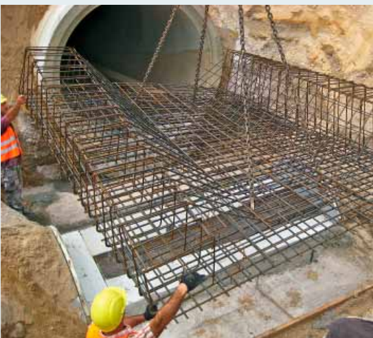
Trassenquerung über vorhandener Kerosinleitung mittels örtlich hergestellter Auflagerplatte
