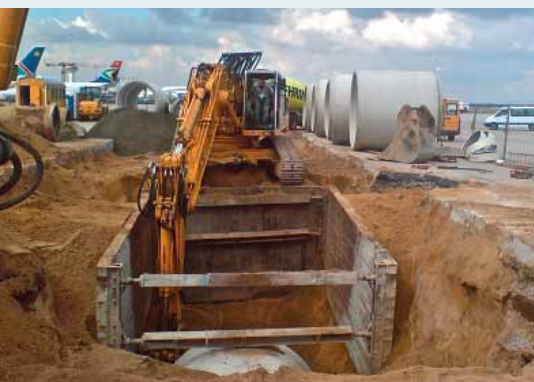
Kraftschlüssiger Verbau im losen Sand. Rundherum auf engstem Raum in Tuchfühlung mit den Flugzeugen auch die Fahrmischer, die den Beton für eine stabile Bettung vor dem Verlegen der Großrohre teils im Schlepptau anlieferten.
