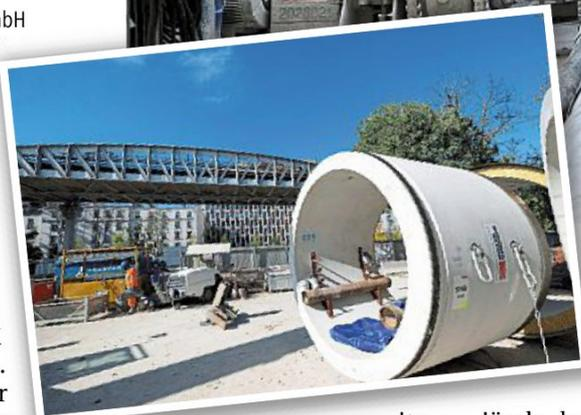
Für den Bau des 635 Meter langen Kanals in 27 Metern Tiefe unter Gelände-/Wasseroberkante nutzten die Arbeiter das Mikrotunnelbohrverfahren. 315 Stahlbetonvortriebsrohre, ausgestattet mit Dichtungen aus Nottuln, wurden verbaut.
